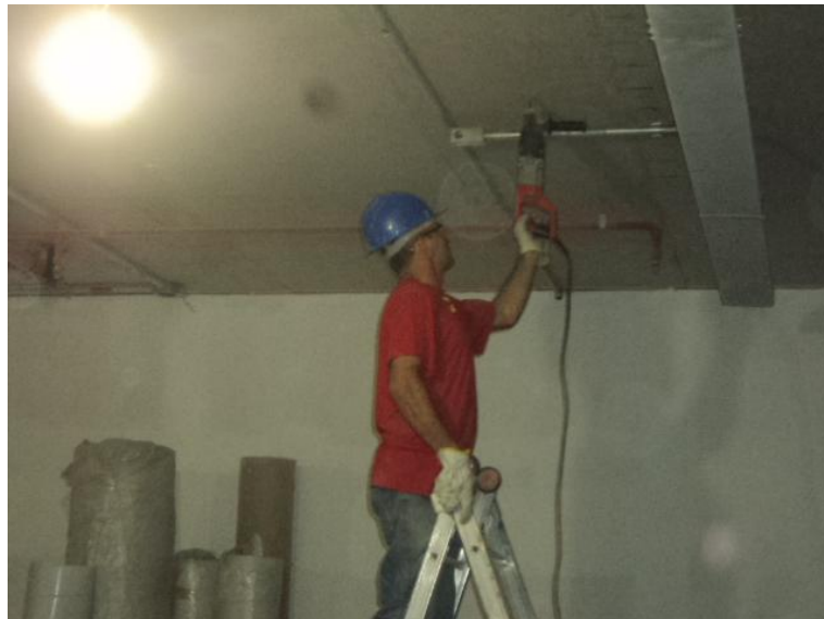
Figura 17 – Furação da laje.
