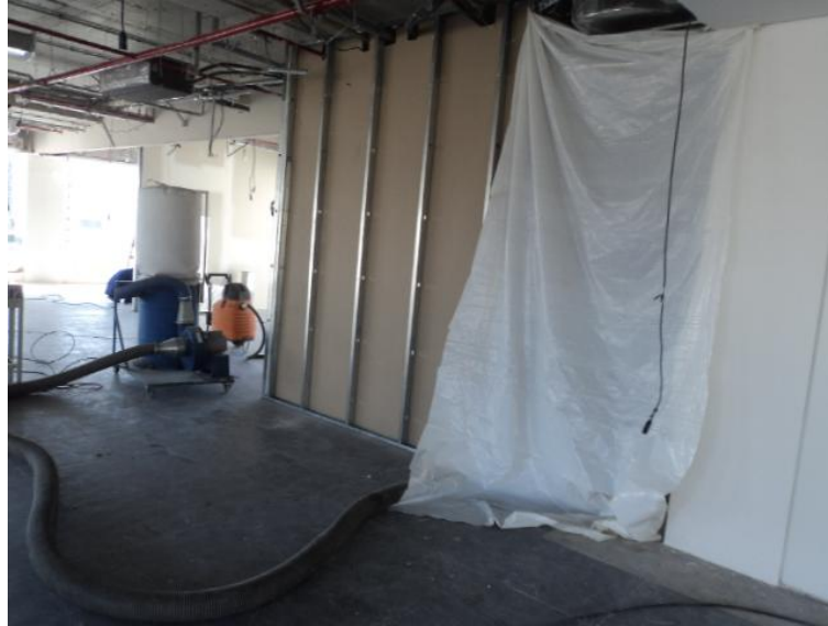
Figura 26 – Barreira para controle de poeira e coletor de pó.
