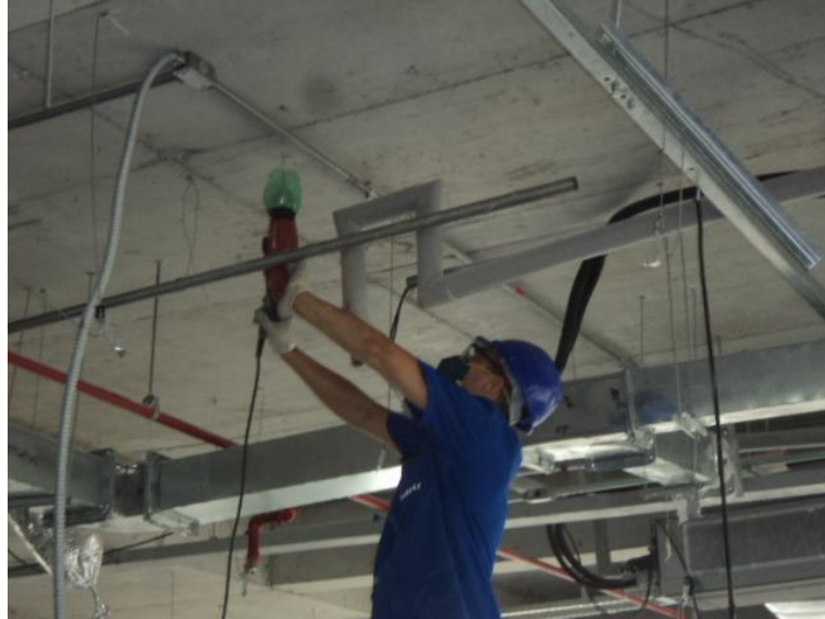
Figura 29 – Adaptação de garrafa PET para coletar o pó da furação do teto.
