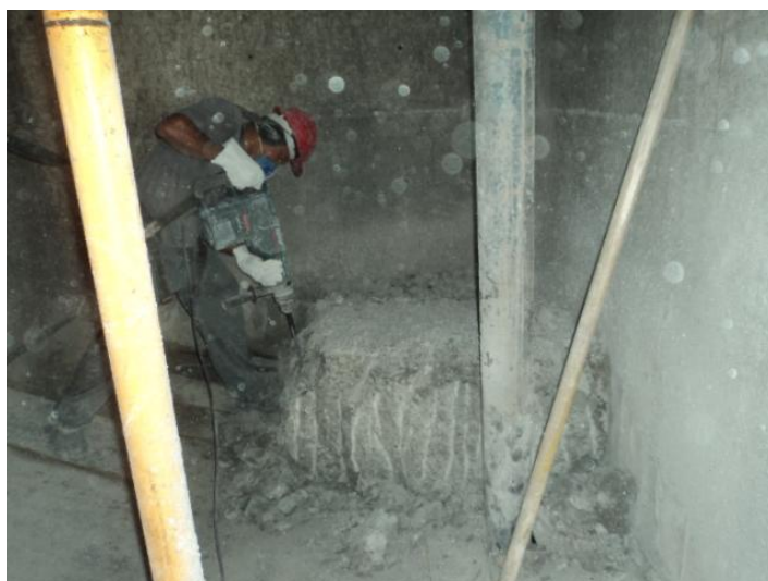
Figura 8 – Quebra de concreto com martelete.
