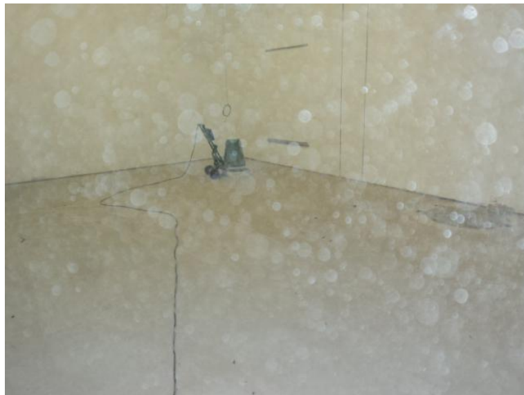
Figura 18 – Raspagem para regularização do piso.
