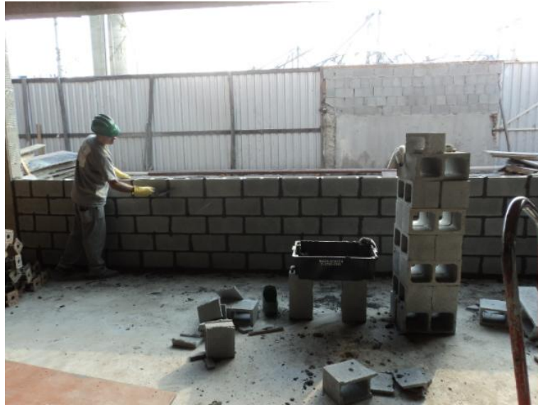
Figura 10 – Alvenaria de vedação com blocos de concreto.
