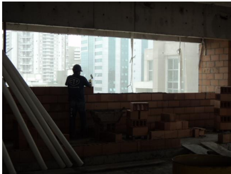
Figura 11 – Alvenaria de vedação com blocos cerâmicos.
