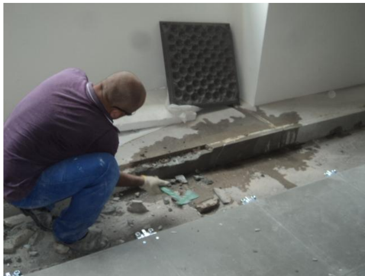
Figura 27 – Umidificação para demolição.
