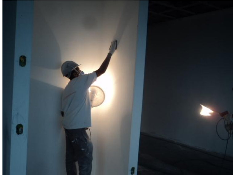
Figura 19 – Lixamento das placas de gesso.
