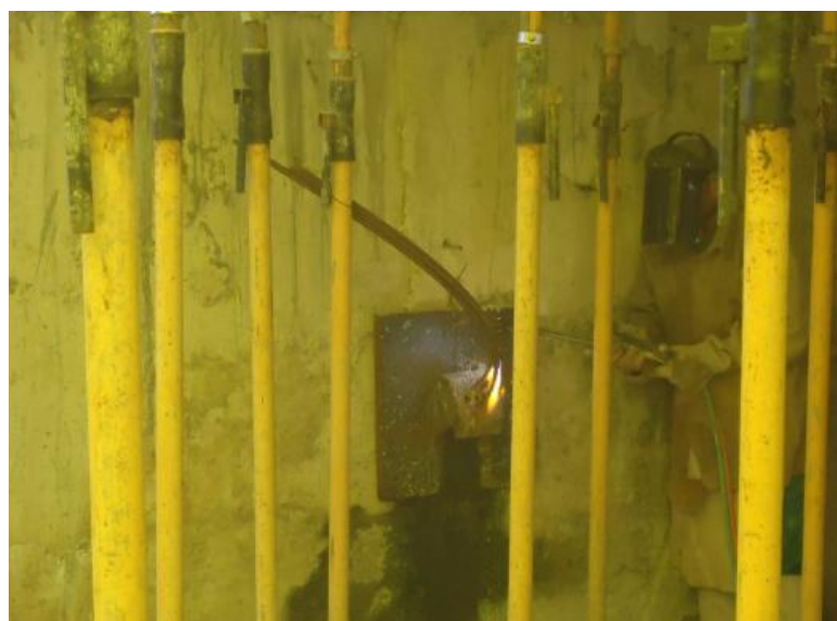
Figura 6 – Corte de tirantes com maçarico oxiacetilênico.
