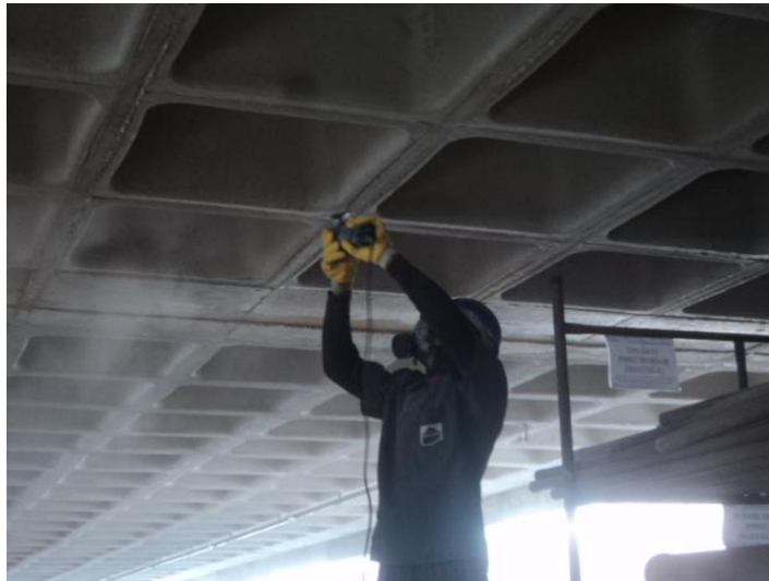
Figura 7 – Lixamento de concreto com lixadeira elétrica.
