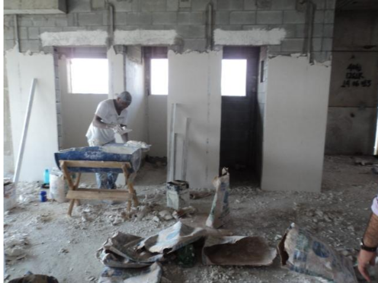
Figura 14 – Aplicação de pasta de gesso nas paredes internas.
