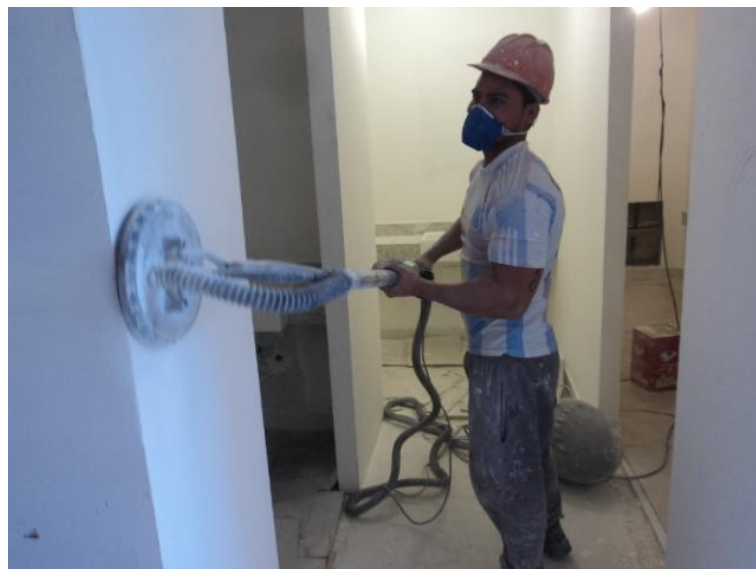
Figura 25 – Lixadeira com aspirador acoplado.
