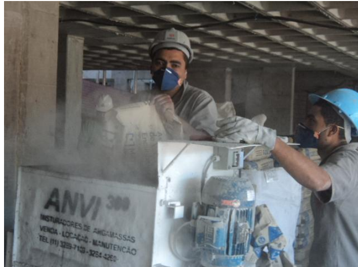
Figura 12 – Mistura de argamassa.
